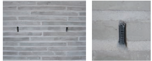
Lüftungs-/Entwässerungsöffnungen; Bild rechts: Gittereinsatz
