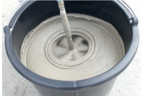
1. Dünnbettmörtel wird nach Anleitung auf dem Gebinde mit Wasser und Quirl klumpenfrei angerührt.
