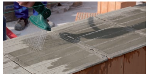
Mörtelpad: Wannenprofilierung auf der Oberseite gewährleistet sichere Wasserdosierung der Bewässerungsvorrichtung
