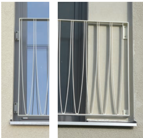
Beispiele für die Befestigung von absturzsichernden Geländern. Links: Befestigung am Fensterrahmen. Rechts: Befestigung an der Außenseite des verputzten Mauerwerks
