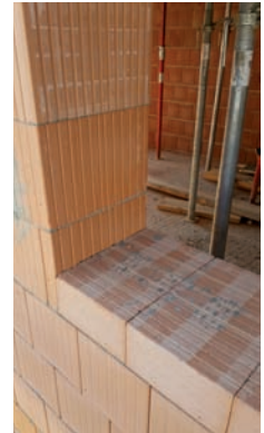
Bilder oben: Rollschicht aus Anfängerziegeln auf Brüstungsoberkante als optimaler Befestigungsgrund zur Fenstermontage;
