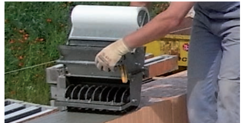
V.Plus: Glasfamentgewebe eingebettet in Dünnbettmörtel
