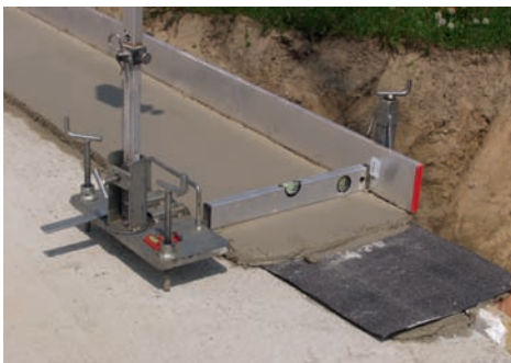
3. Kontrolle der waagerechten Lage des Mörtelbettes
