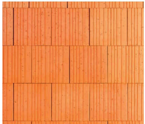
Planziegelmauerwerk (Steinhöhe 249 mm, Lagerfuge 1 mm)
