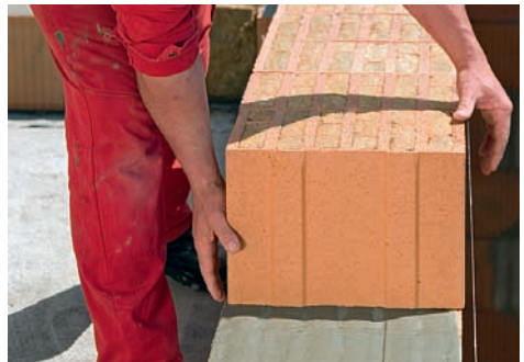
5. Planziegel werden in der Regel "knirsch" (unvermörtelte Stoßfuge, b \leq 5 \text{ mm} ) im frischen Dünnbettmörtel versetzt.
