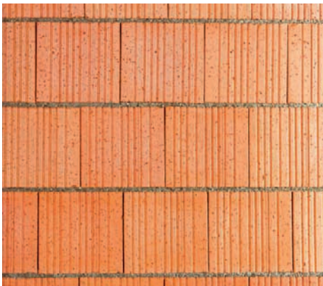
Blockziegelmauerwerk (Steinhöhe 238 mm, Lagerfuge 12 mm)
