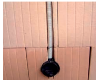
Einlegen der Elektroinstallation in die Schlitzte.
