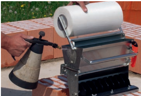
2. Vor dem Befüllen mit Dünnbettmörtel wird die Mörtelwalze (hier System V.Plus) mit einem Trennmittel benetzt.
