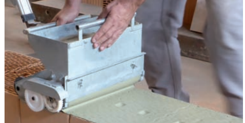
VD: Vollflächiges Dünnbettmörtelband auf Planhochlochziegel
