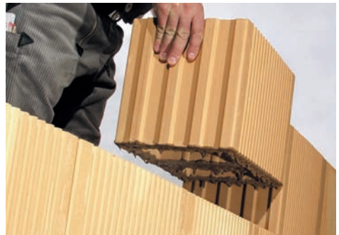
2. Mit Dünnbettmörtel benetzte Lagerfläche
