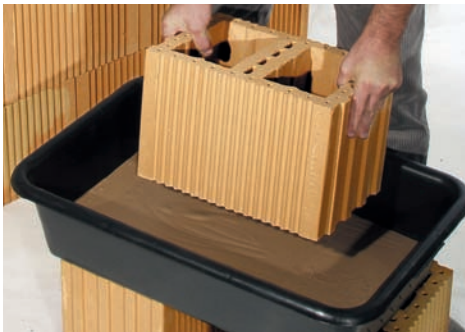
1. Plan-Füllziegel wird in Dünnbettmörtel getaucht, so dass die Lagerfläche mit Mörtel benetzt ist
