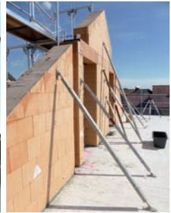
Montage Ziegelwand-Fertigteilelemente 2017 (KfW-EH-55)
