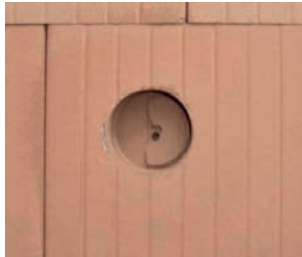
Ziegelreste und Bohrmehl entfernen.
