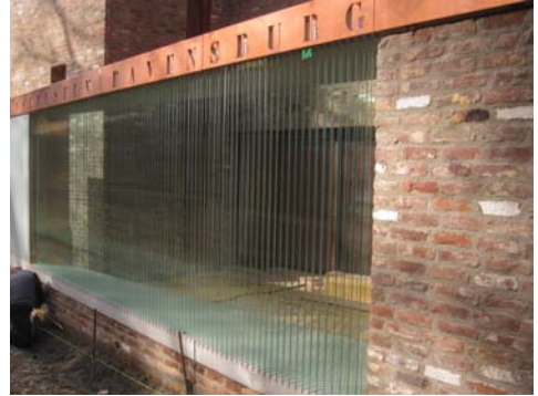
Fassade aus Recyclingziegeln, Kunstmuseum Ravensburg, 2013
