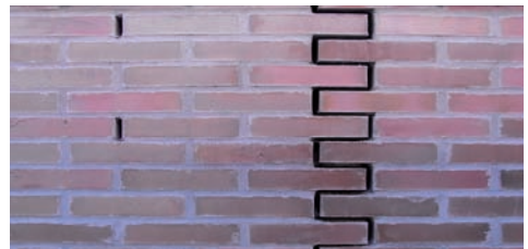
Vertikale Dehnungsfugen, als Mäander ausgeführt im Zustand vor der Füllung mit elastoplastischer Fugendichtmasse
