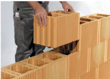
3. Plan-Füllziegel wird mit einem Versatz (Überbindemaß) einer halben Steinlänge verarbeitet.
